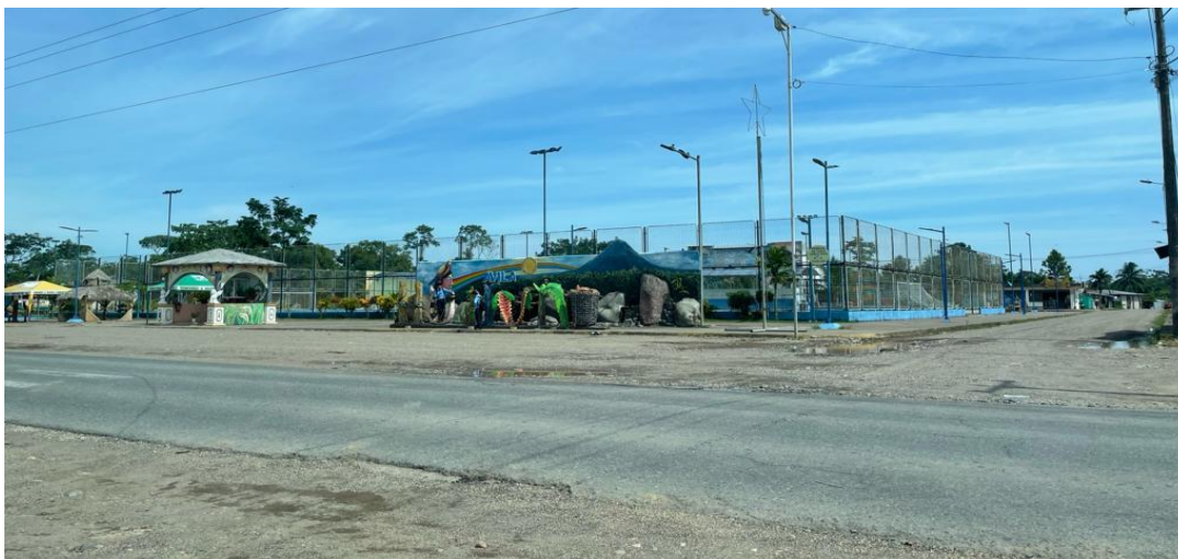
Figura 76 Imagen de rodadura con asfalto en sector de parque temático Ávila Huiruno
