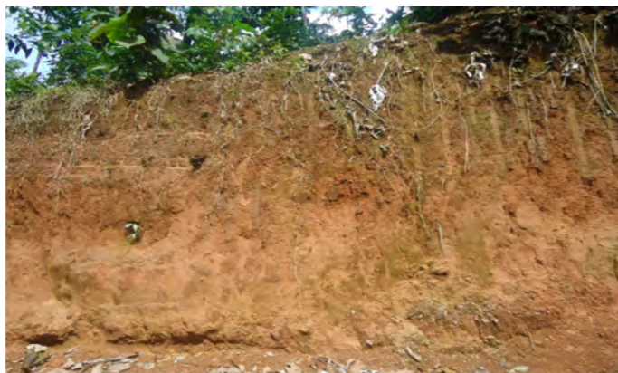
Taludes en las vías con cortes rectos con peligro de derrumbarse en épocas invernales. Quema de bosques y potreros en algunas comunidades .
