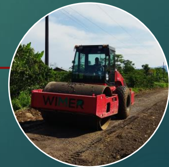
EQUIPO DE COMPACTACION
