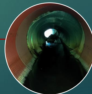
ALCANTARILLA DEFORMADA
